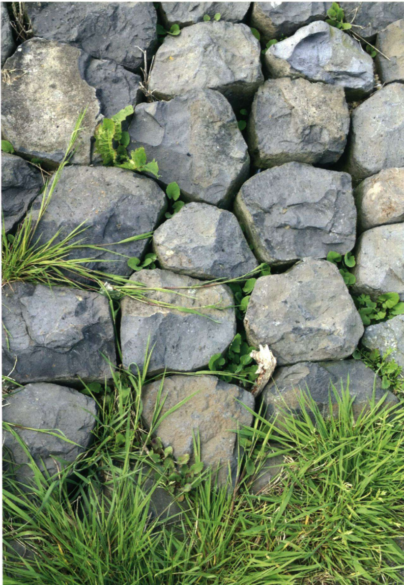
AFBEELDING 2. | Basaltzuiltjes passen netjes aan elkaar en maken zo een stevige verdediging tegen het water.
