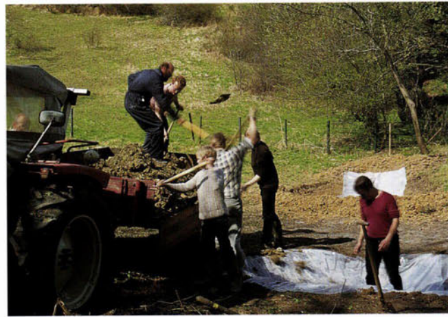
FIGUUR 3 Het graven van een pool in de Berghofweide met behulp van plastic en klei (foto: A. Lenders).
