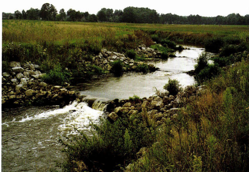
FIGUUR 7 Stortsteendrempel met teveel verval bij de Beerze, Spoordonk (foto: P. Voorn).
