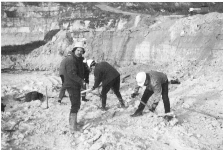
FIGUUR 1 Het terrein wordt vrijgemaakt (foto W.M. Felder).
