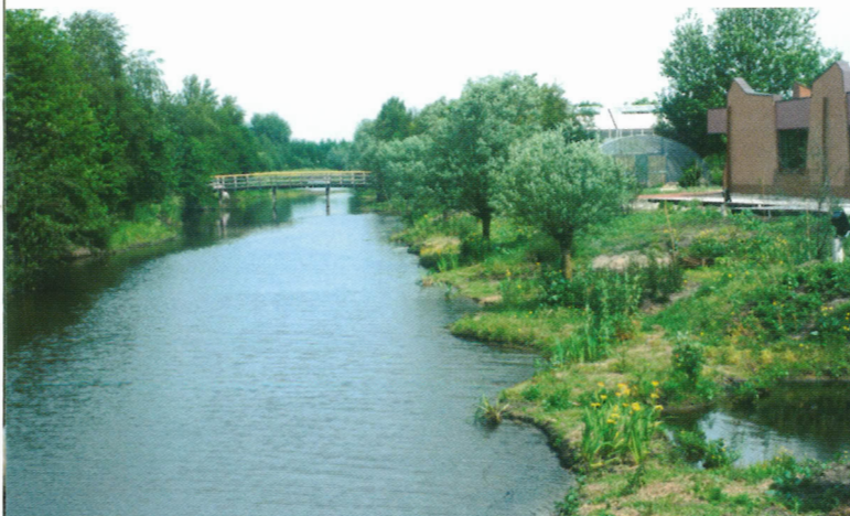
● VSM-oeverproject met IJsvogelwanden een half jaar na aanleg, mei 1999. Foto: Jan Stok.
