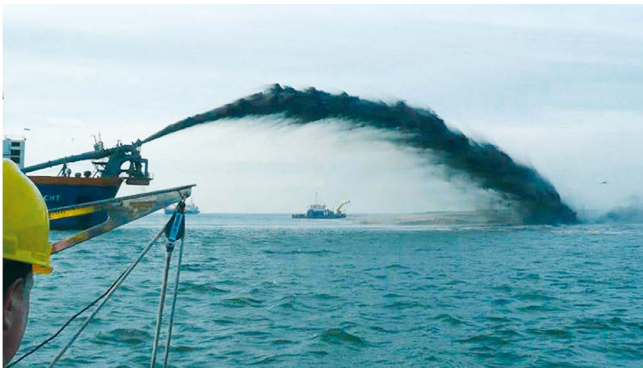
AFBEELDING 2. | Rainbowing van het opgezogen sediment om het nieuwe land te creëren. Foto: T. van Kolschoten.
