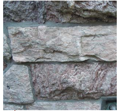
AFBEELDING 28. | Bleek-roze tot rozig grijs gepatineerde bouwstenen uitgevoerd in verschillende variëteiten van Rood marmer van Baelen aan dezelfde plint als in afbeelding 27. Centraal: rode stromatactis-kalksteen, onder en boven: rode “erwtenstein”-variëteit. Foto: P. Elst.
