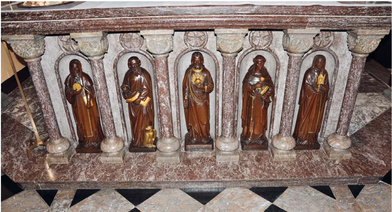
AFBEELDING 29. | Communiebank uitgevoerd in gepolijste rode “erwtenstein” en vloertegels uitgevoerd in grijze, roze en rode stromatactis-kalksteen (i.c.m. Belgisch zwart marmer) in de 19e-eeuwse Kapel van het Home Saint-Joseph, Baelen-Les Forges.
