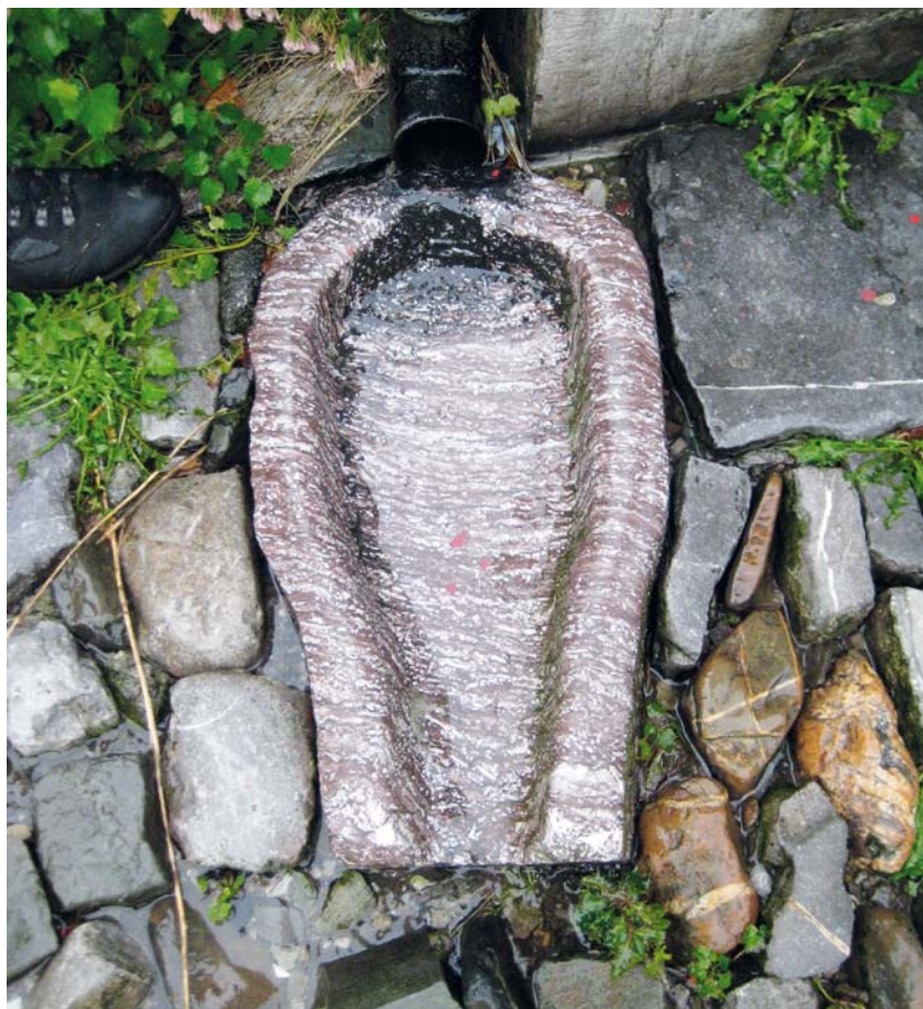
AFBEELDING 26. | Originele gootsteen uitgevoerd in rode “erwtensteen”-variëteit van het Rood marmer van Baelen op de Place Saint-Georges, Limbourg Ville Haute, België.
