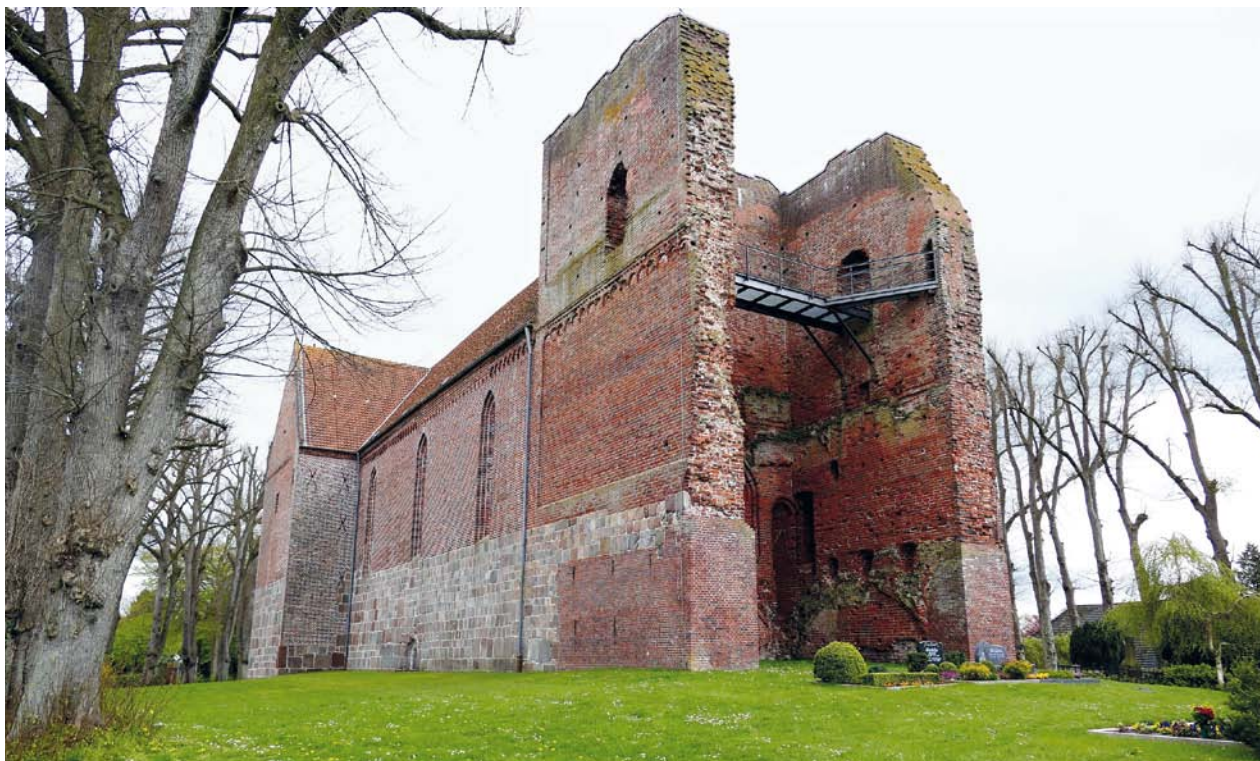
AFBEELDING 15. | De kerk van Reepsholt is een bezienswaardigheid door de al vele honderden jaren oude torenruïne. In de 15e eeuw zijn tijdens een burgeroorlog delen van kerk en toren ingestort. De kerk is boven de zwerfstenen onderbouw in gotische stijl herbouwd; de toren bleef zoals hij was.
