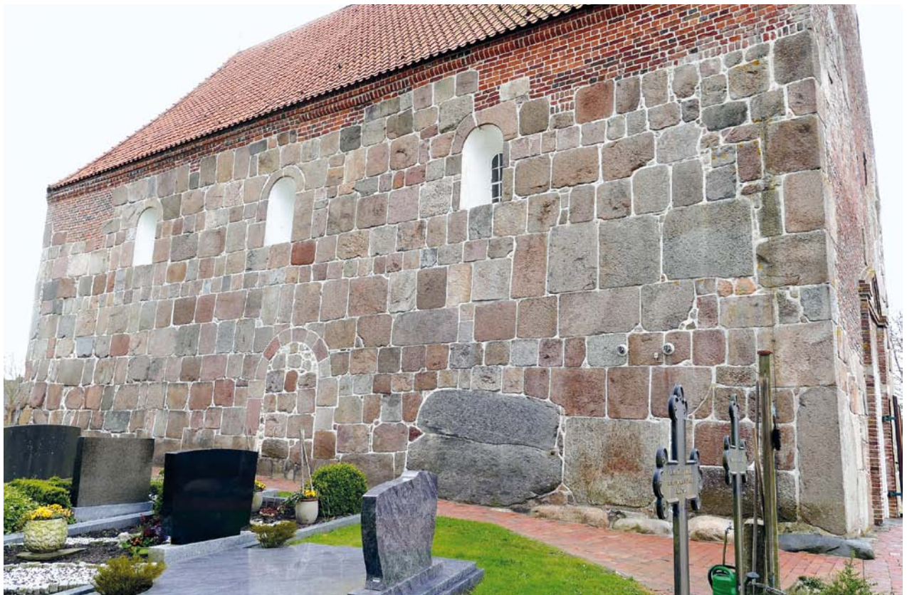
AFBEELDING 18. | In de noordmuur van de kerk van Marx zijn een paar bijzonder grote zwerfkeien verwerkt. In de muur zijn de twee gespleten helften van één donkere hoornblendgneis verwerkt. Minstens zo opvallend is de grote rechtopstaande hoeksteen.
