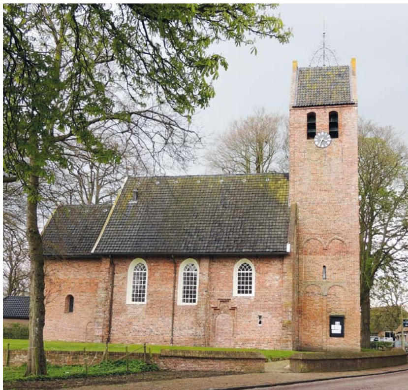
AFBEELDING 9. | De bakstenen Bartholomeuskerk van Noordlaren. Zwerfstenen werden uitsluitend verwerkt in fundamentstroken onder toren en kerk. De dikke kerkmuren bestaan uit kistwerk, met een muurvulling van zwerfkeiën, baksteenafval en schelpkalk.
