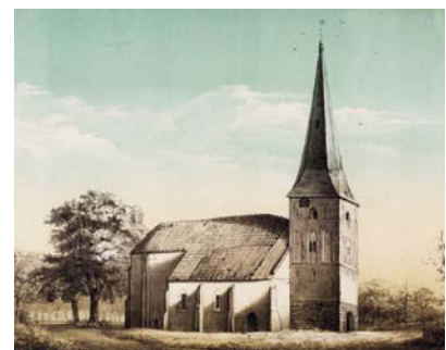
AFBEELDING 4. | Een oude tekening van de middeleeuwse Sint Pancratiuskerk in Emmen. De romaanse toren met zijn onderbouw van grote, gekantrechte zwerfsteenblokken ('hunebedbrokken') dateert uit de 12e of 13e eeuw. Het schip van de kerk is in de 19e eeuw afgebroken en vervangen door de huidige kerk.
