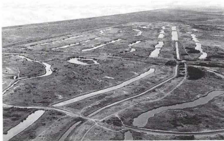
In de vorige eeuw is in de AW-duinen een groot infiltratieveld aangelegd voor de produktie van drinkwater (foto: GWA).
