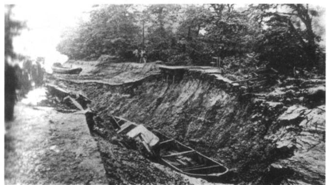
Afb. 5. Twee voorbeelden van verzakkingen veroorzaakt door de zoutwinning. (bron: Lion Salt Works)
