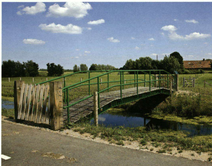
Over de Laak, op de grens tussen Utrecht en Gelderland, is een nieuwe voetgangersbrug aangelegd. Deze vormt een verbindingsschakel in een klompenpad door een weidevogelrijk gebied. Foto: Wim Smeets.
