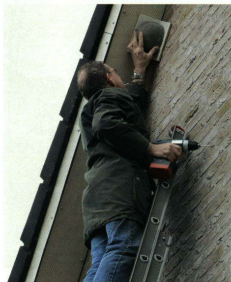
Het plaatsen van een kunstnest onder een dakrand. Foto: Bert Peters.
