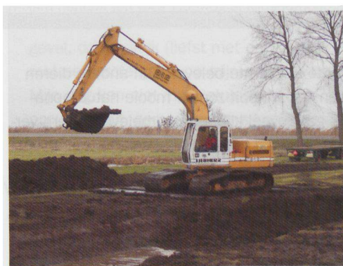
Graafwerk in de Uithoornse Polder.
