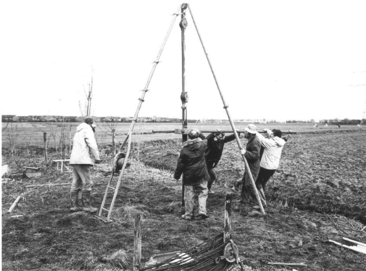
Het trekken van de mantelbuis van boring Zuurland-1. Maarten van den Bosch (geheel links) en Anton Janse (geheel rechts) in actie.
