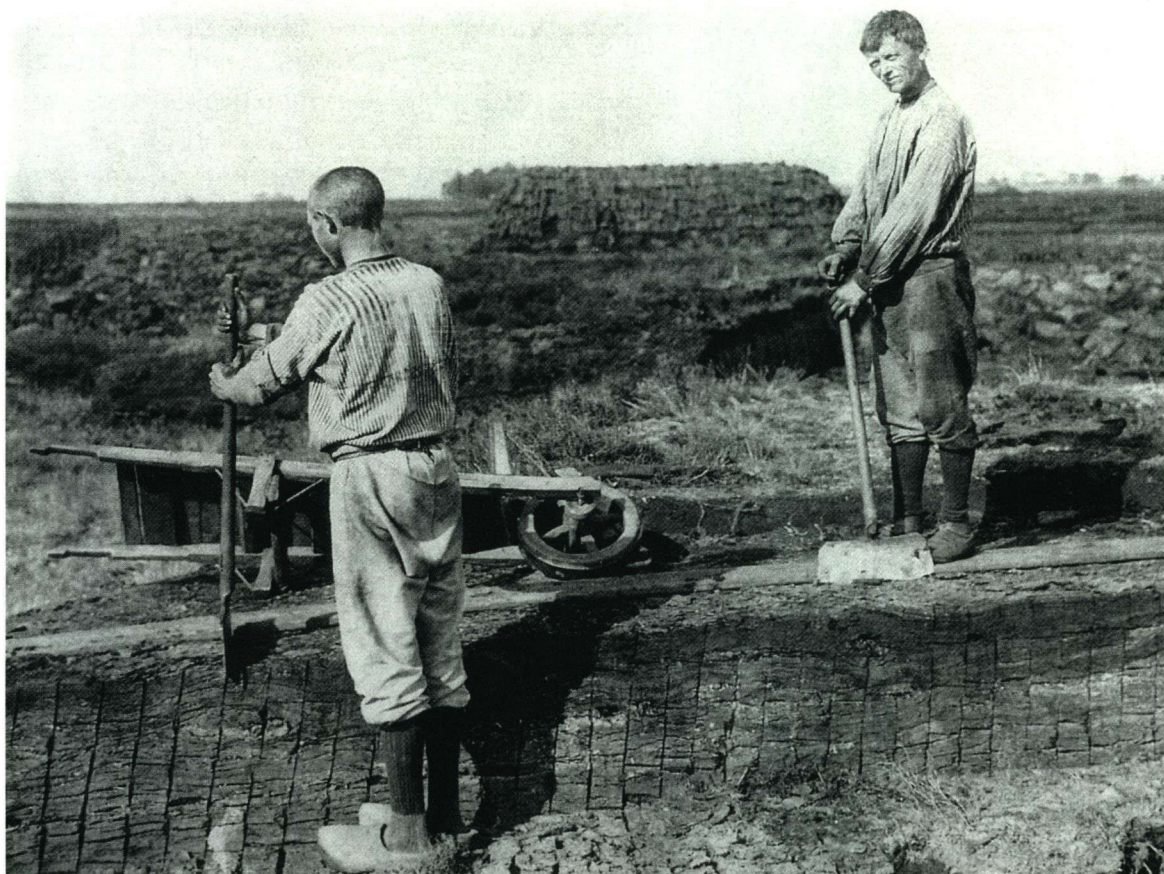
Afbeelding 2. De meeste vondsten in het Drents Museum zijn gevonden bij het turfgraven, dat in de tweede helft van de negentiende eeuw zijn hoogte- punt beleefde. Foto: Drents Museum, Assen.
