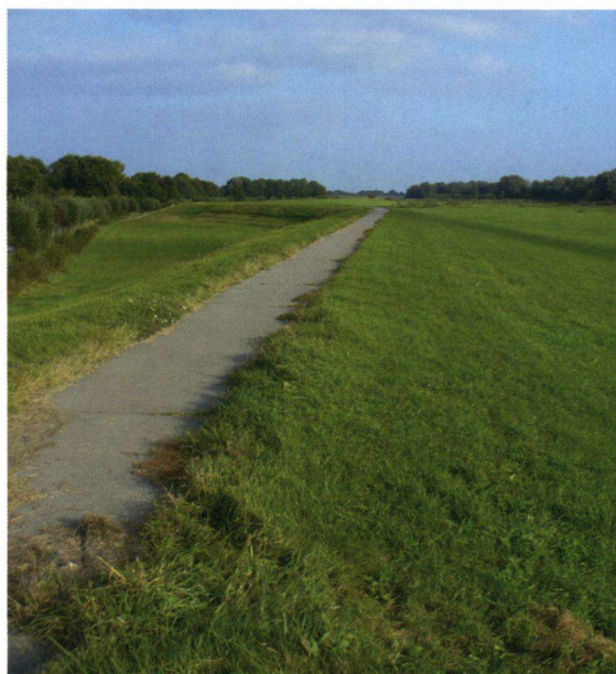
Afbeelding 10. De dijk van de Bentpolder die op een voormalige kustwal is gebouwd.
