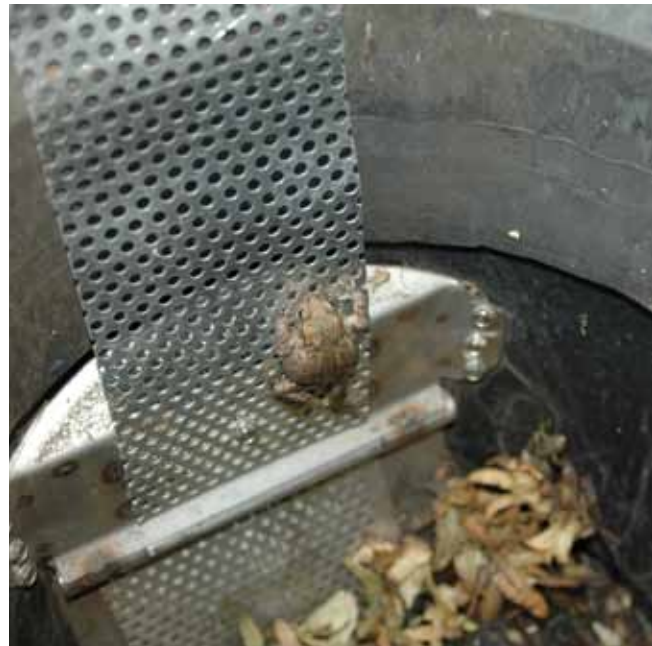
Bij een pilot in Amsterdam, waarbij in 400 straatkolken metalen geperforeerde strips tegelijk met een nieuwe putklep werden ingebouwd, maakten nog tijdens de montage de padden al gebruik van de uitklimstrip. (Leverancier: Struyk Verwo Aqua; Foto: Waternet)
