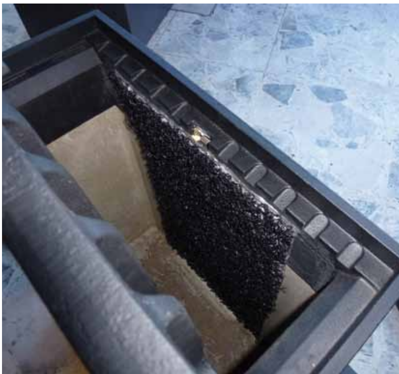
De uitklimmat biedt goede grip voor naar boven klimmende amfibieën en kleine zoogdieren (Leverancier: Aco-Pro; Foto: Annemarie van Diepenbeek)
