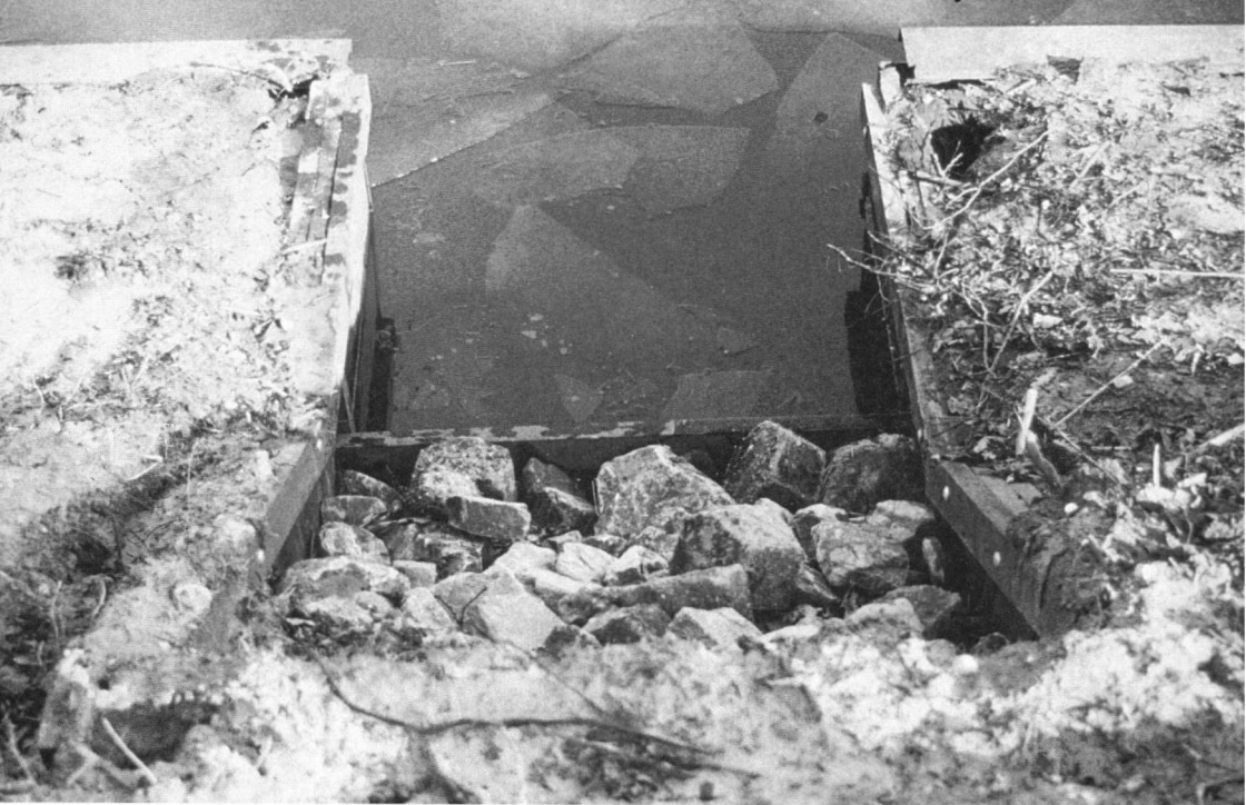
Figuur 3. Kleine faunauitstapplaats van circa één meter breed. Foto Jeroen Reinhold
