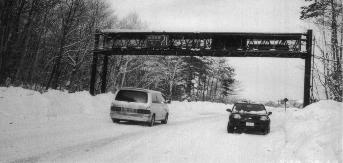
Foto 2: Portaal voor wegsignalering aangepast op medegebruik van relmuis. Foto: Minato, Japan
