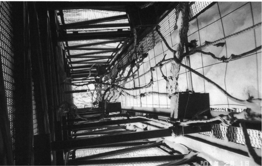
Foto 3: Brug voor relmuizen langs wegportaal in Japan met nestkasten (rechtsonder) voor dekking en lianen als looptakken. Foto: Minato, Japan
