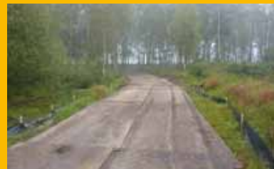
Rijplaten, noodzakelijk om de ruim 1800 vrachten met verontreinigd slib af te voeren, werden iedere keer kort voor aanvang van de werkzaamheden neergelegd om te voorkomen dat amfibieën en reptielen zich eronder verstopten. (Foto: Hans Teeven)
