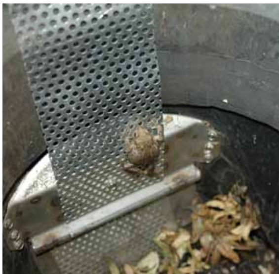
Geperforeerde stalen strip, hier een constructie in combinatie met een putklep (Struyk Verwo Aqua)
