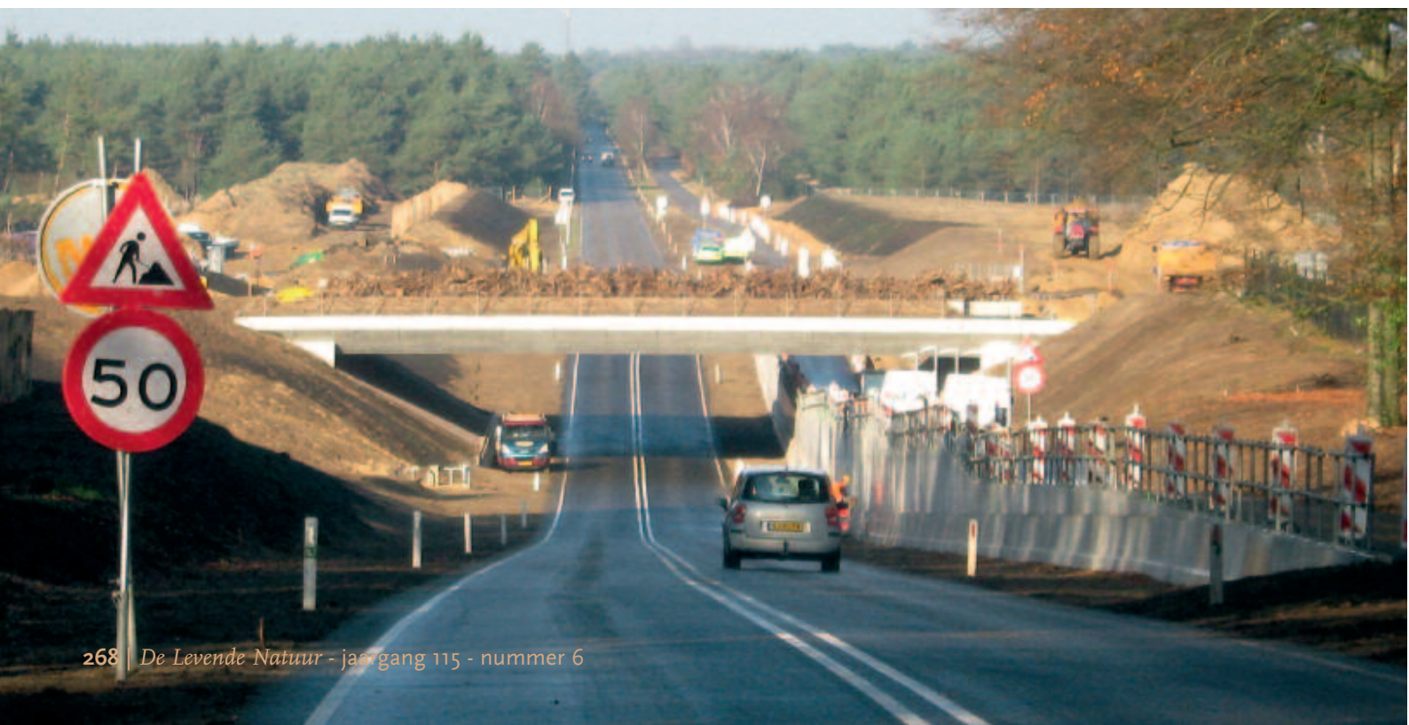
Foto 1. Ecoduct Oud Reemst in aanbouw. Voor de aanleg is de provinciale weg N311 verdiept (foto: Het Nationale Park De Hoge Veluwe).
